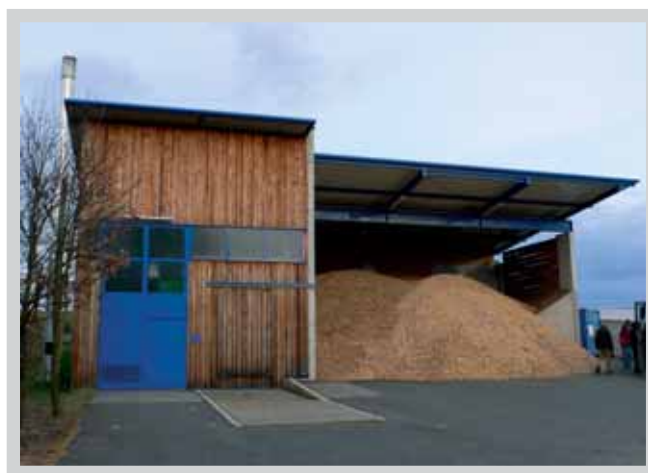
Výtopna na biomasu pro malou obec. Foto: Karel Srdečný, EkoWATT
