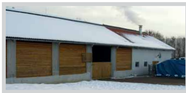
Výtopna na štěpku se skladem paliva, Hostětín. Foto: Monika Kašparová, EkoWATT
