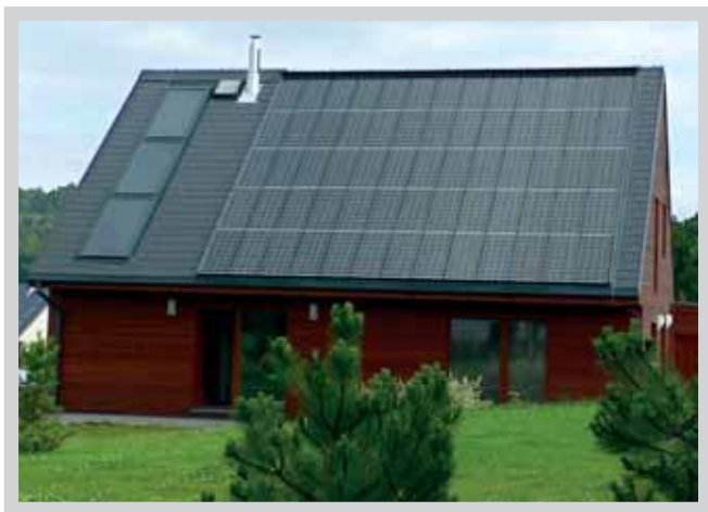
Solární systémy pro ohřev vody (vlevo) a pro výrobu elektřiny. Foto: Atrea
