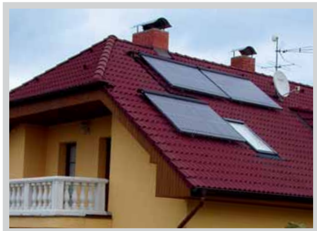
Solární systém pro ohřev vody. Foto: Monika Kašparová, EkoWATT
