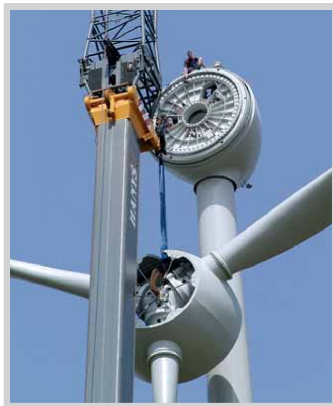
Montáž větrné elektrárny. Foto: Jiří Beranovský, EkoWATT
