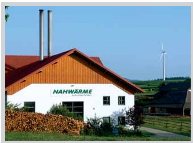
Výtopna na dřevo a větrné elektrárny zajišťující energetickou soběstačnost obce (Rakousko). Foto: Karel Srdečný, EkoWATT
