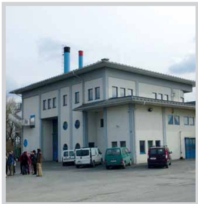
Elektrárna spalující biomasu (Rakousko). Foto: Jan Truxa, EkoWATT
